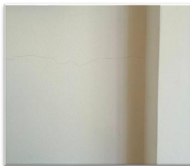
ภาพที่ 3.1 หาจุดที่จะติดตั้ง Smart Air Controller
