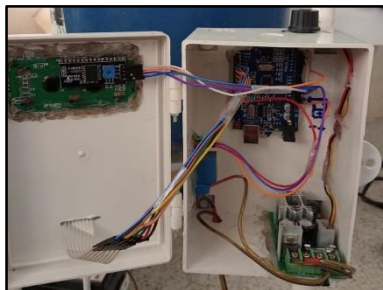
ภาพที่ 3.2 ติดตั้งอุปกรณ์ในกล่อง
